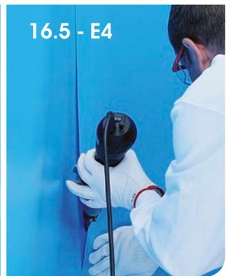
F. Jetzt kann die Ecknaht mit der finalen Schweißung mit Hilfe des Schweißgeräts und der Anpressrolle fertiggestellt werden. Dabei ist zu beachten, wenn die Naht direkt in der Kehle verläuft mit der Andrückrolle direkten Druck auf die Rundung der Hohlkehle auszuüben. Abschließend muss jede Naht mit der Prüfnadel geprüft werden.
