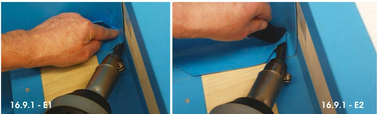
F. Diese Schritte wiederholen sich, bis alle Ecken verschweißt sind und die Überlappungen vollflächig auf den Folienverbundblechprofilen aufgeschweißt sind. Anschließend erfolgt die Installation der nächsten Wandbahn.
