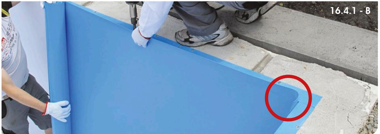
**C.** Überlappung am Boden beachten: ca. 100 – 150 mm (siehe Abbildung). Diese Überlappung aus der Kehle des Beckens leicht herausziehen (ca. 20 – 30 mm), um dem Material etwas Vorspannung zu geben, damit der Wasserdruck später die Schwimmbadbahn an der Wand entlang straffen kann.
