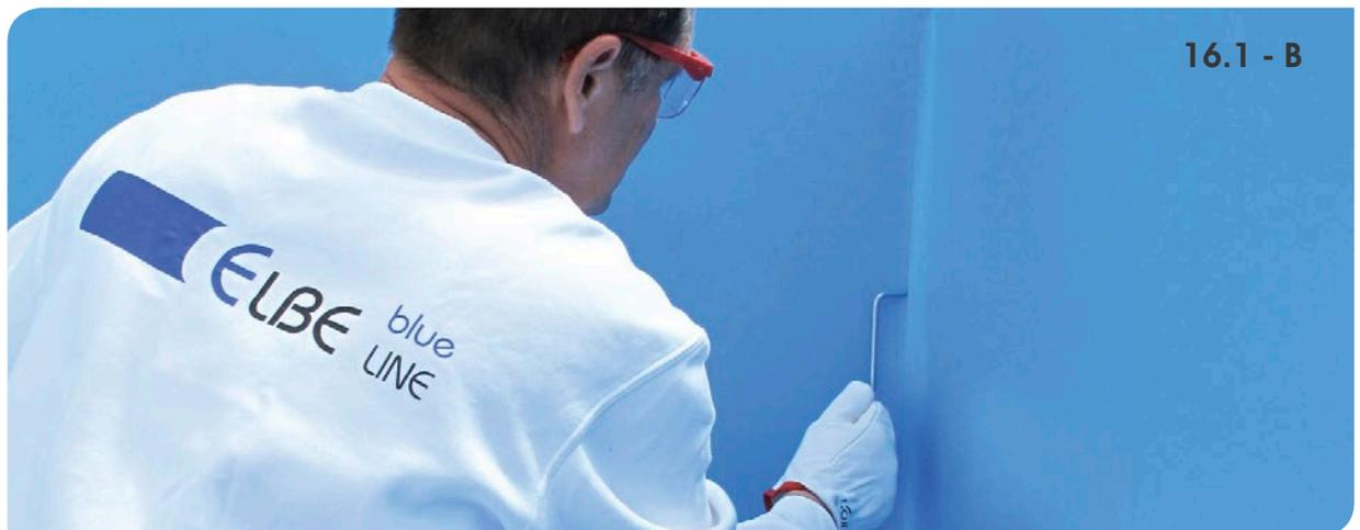
C. Abschließend wird jede Schweißnaht mit **Nahtversiegelung (Flüssigfolie)** versiegelt. (siehe Abbildung; **ACHTUNG:** Trocknungszeit ca. 30 min):
