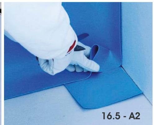
**B.** Die Überlappung für die Ecke wird entsprechend der Abbildung gefaltet.
