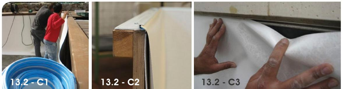
**D.** Mit dem Klemmstreifen (oder auch Klemmprofil) wird die Wandbahn gegen Herausrutschen gesichert.
