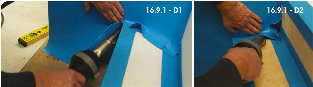
E. Im Anschluss werden die Ecken aus den Überlappungen der Wandbahn verschweißt.
