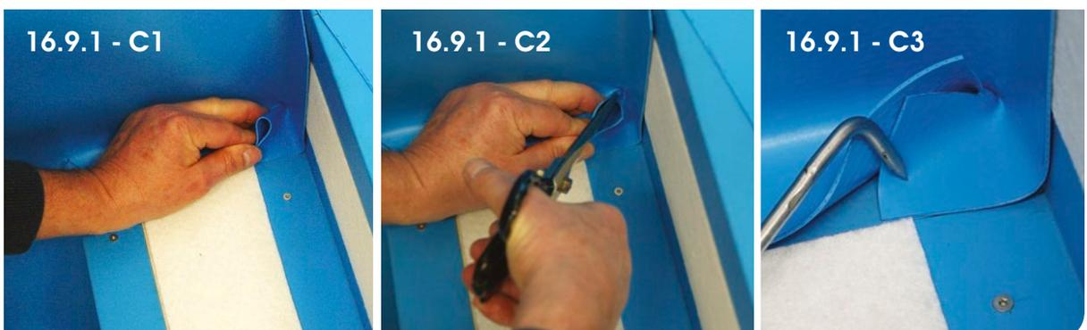
D. Jetzt wird die Folie an den Verbundblechprofilen an der Wand angeheftet.
