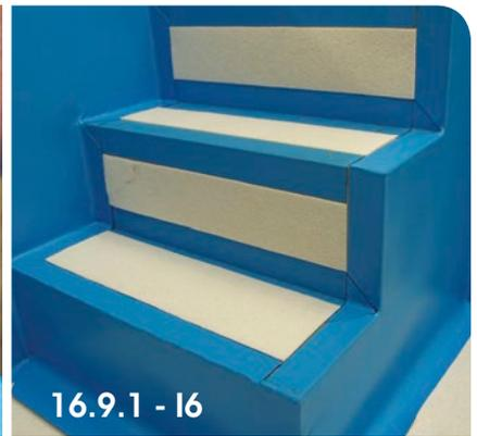
J. Bei den weiteren Stufen können Tritt- und Setzstufe auf 1) einem Stück verschweißt werden oder 2) jeweils aus Einzelteilen.
