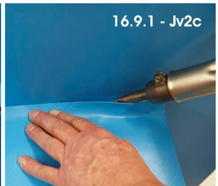
**K.** Nach dem kompletten Verkleiden der Treppe wird auf die Setzstufen die Trittschutzfolie (Antirutschfolie) aufgeschweißt.
