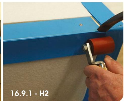
**I.** Jetzt kann die Auskleidung der unteren Setzstufe erfolgen.
