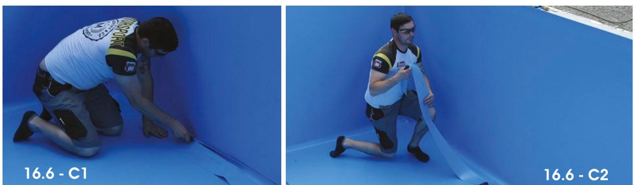
**D.** Die fertig eingepassten Bodenbahnen werden mit einer Überlappung von ca. 50 – 70 mm am Beckenboden ausgelegt und mittels einfacher Schweißnaht miteinander verbunden. Hier erfolgen wieder die Arbeitsschritte 1. Fixieren; 2. Heftnaht; 3. Finale Schweißnaht mit Andrückrolle.
