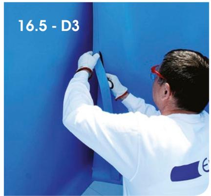
E. Die überlappende Wandbahn jetzt wieder leicht aus der Eckkehle des Schwimmbeckens herausziehen, damit auch hier eine Vorspannung entsteht. Mit dem Schweißgerät fixieren und darauffolgend die Heftnaht schweißen (siehe Abbildungen).
