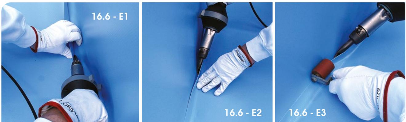
**F.** Sind Wände und Boden fertig verschweißt, erfolgt die Versiegelung der Nähte mit Flüssigfolie. Danach wird der Bodenablauf abgedichtet.
