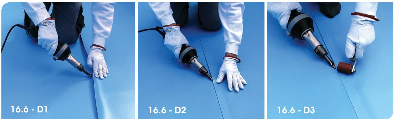
**E.** Als nächstes wird der Boden mit der Wandbahn verschweißt. Dabei ist darauf zu achten, dass die Wandbahn genügend vorgespannt wird, damit eine leichte Hohlkehle hinter der Folie entsteht. Auch diese Naht wird wieder in den 3 Arbeitsschritten (siehe Punkt 16.1 »Einfache Naht (2 Lagen) / Nahtversiegelung«) ausgeführt. Die Rollbewegung (3. Bild) muss direkt in die Hohlkehle hinein und über die Nahtkante hinweg erfolgen.
