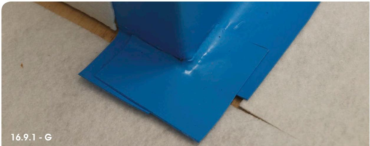
**H.** Ausbildung einer Außenecke (falls vorhanden). Die dadurch entstehenden Überlappungen werden später durch den Boden abgedeckt.
