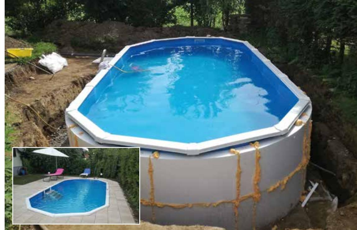
Der **PROTECTOR** Isolations- und Druckschutz wurde nur für KWAD Stahlwandpools der Serie „SUPREME“, „Steely de Luxe“, „White Wood“ und „Design“ (Rund & Oval), entwickelt.
